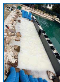
Abb.8 Skimmerteich eines TEOC Naturpools beim Bubbeln (Rückspülen)...
